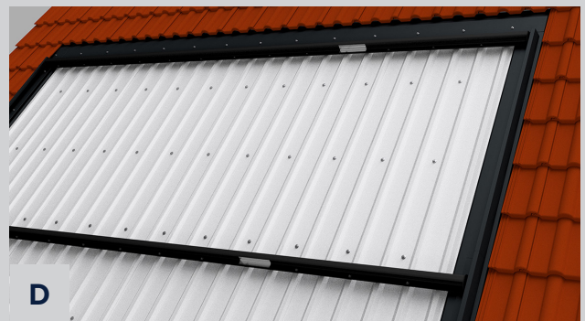
D Kabelfangnetze anbringen
