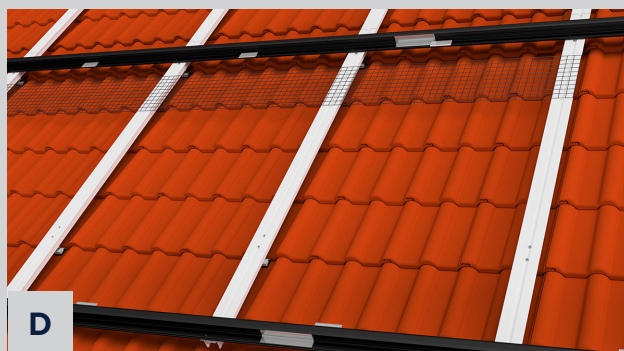
D Kabelfangnetze anbringen
