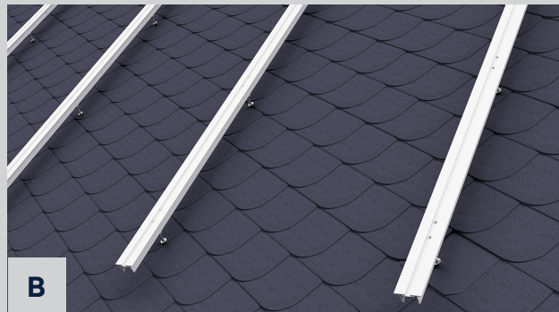
B Vertikalprofile auf Vertikalaufsätze verschrauben
