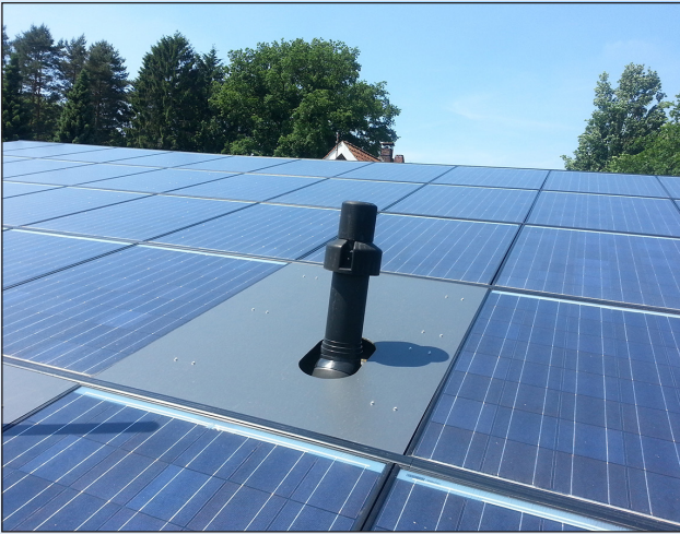
Einsatz von SOL-50 Spezialprofil zur Verbindung von Störflächen
