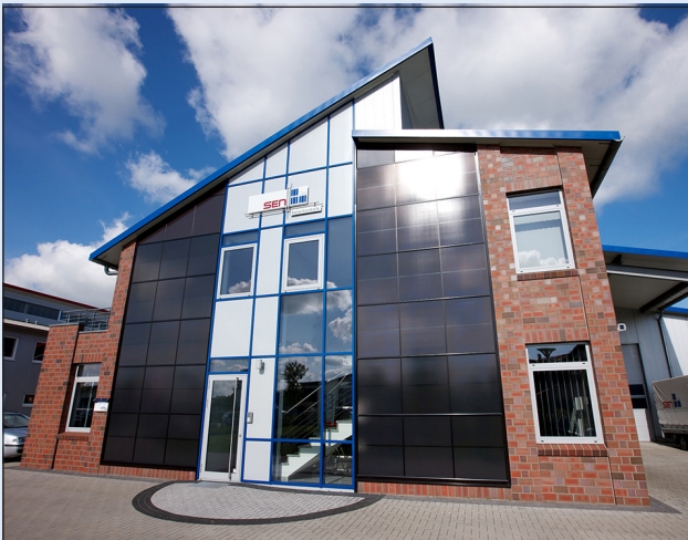
SOL-50 Fassadenanlage mit Verblendern in der Schräge, Premium schwarz pulverbeschichtet
